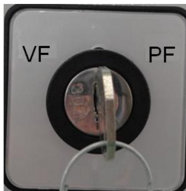
Рис. 3 Переключатель работы двигателя от преобразователя / от сети
