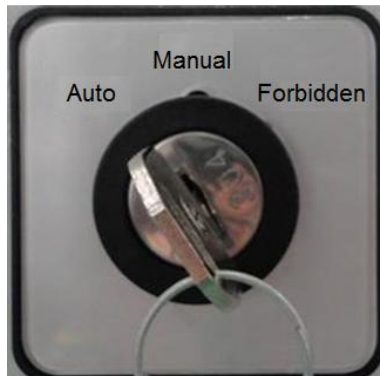
Рис. 2 Переключатель режимов работы шкафа автоматического шунтирования
