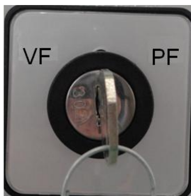
Рис. 4 Переключатель работы двигателя от преобразователя / от сети
