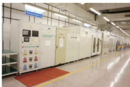
Зона проверки функционирования силовых ячеек
